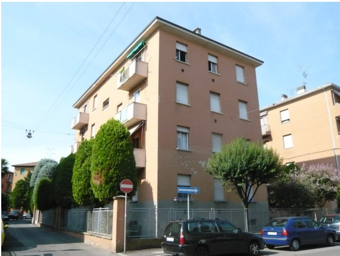
1. Vista da nord-est: scorcio da via Sciesa
