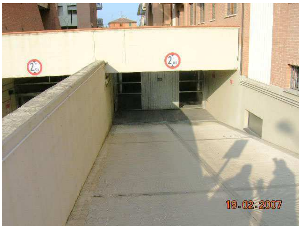
Rampa di accesso alle autorimesse
