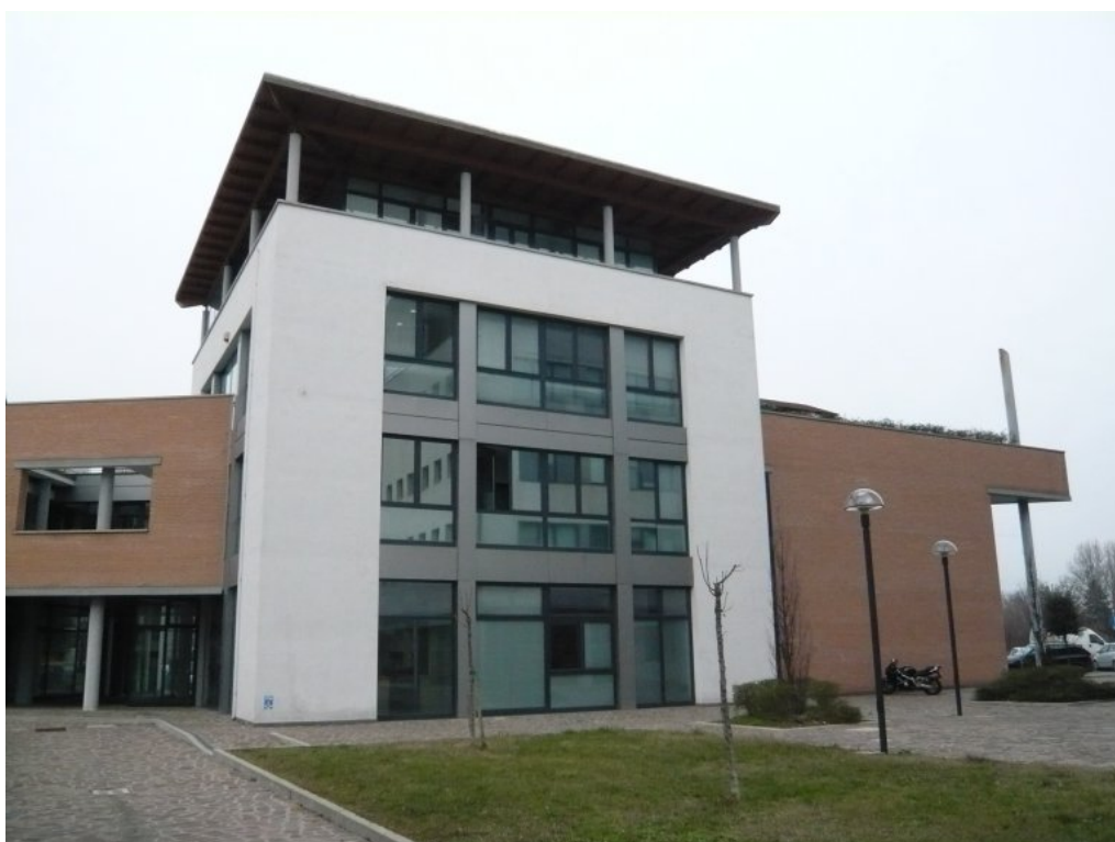
2. Fronte est dell'edificio
