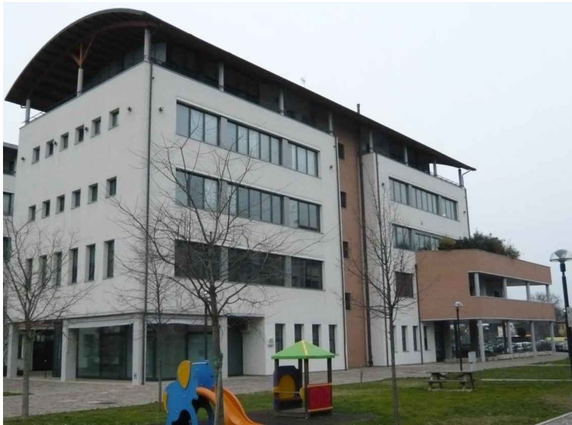
2. Scorcio da est dell'edificio
