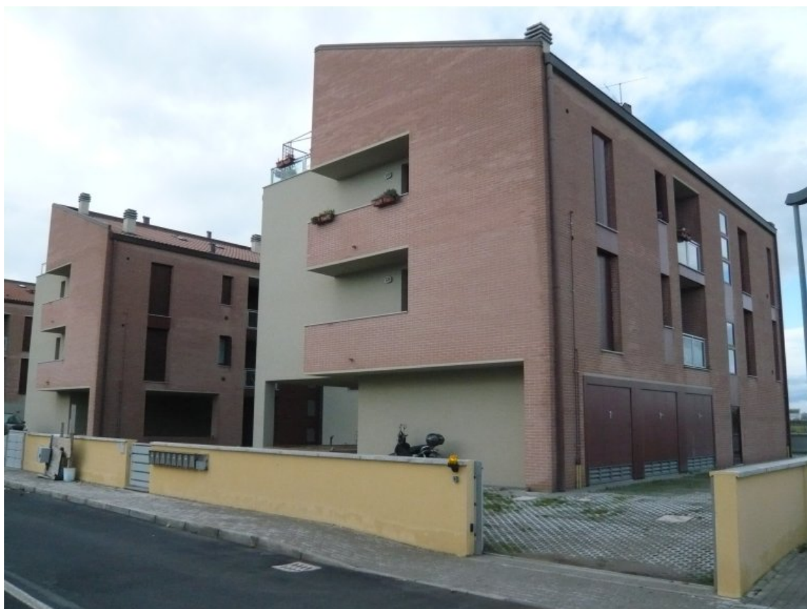
1. Scorcio del fabbricato da nord-est
