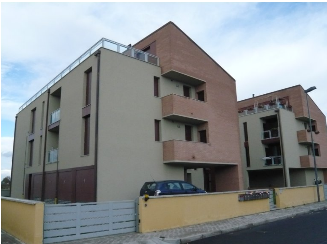
2. Scorcio del fabbricato da sud-est
