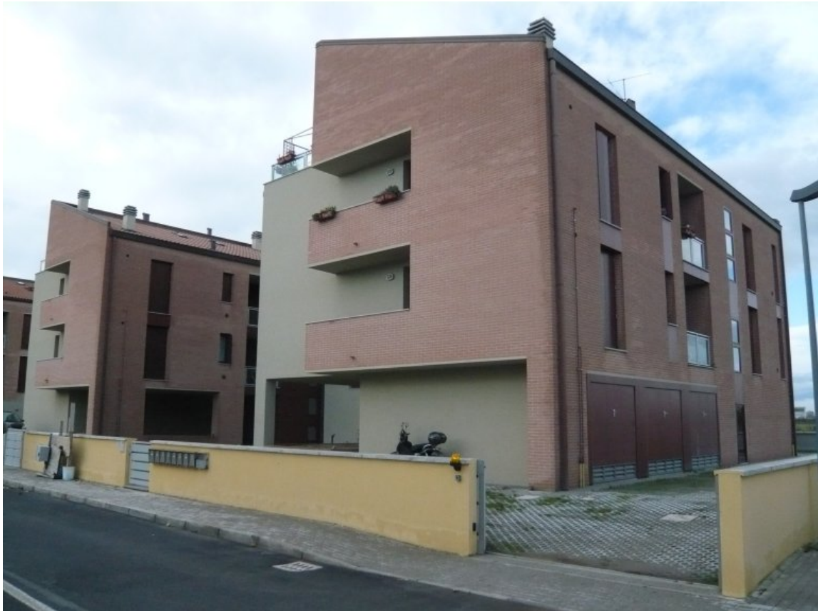
1. Scorcio del fabbricato da nord-est
