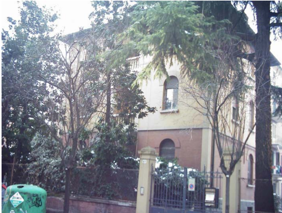
Figura 1 - VISTA DA VIA MARC'ANTONIO RAIMONDI - FRONTE PRINCIPALE.
